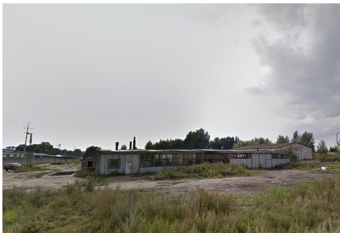
Fotografia 4. Zabudowa sąsiadująca z obszarem objętym miejscowym planem zagospodarowania przestrzennego (widok A).
