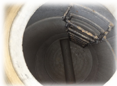
Budowa sieci kanalizacji sanitarnej przy ulicy Rolnej w Zalewie
