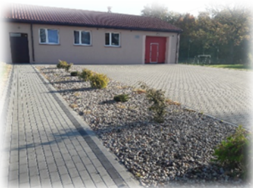
Wykonanie podjazdu pod remizę OSP Janiki Wielkie
