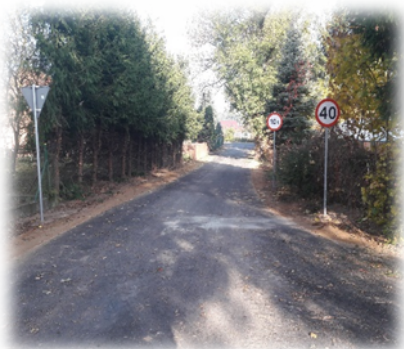
Przebudowa drogi gminnej w miejscowości Witoszewo
