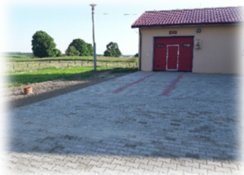
Wykonanie podjazdu pod remizę OSP Dobrzyki
