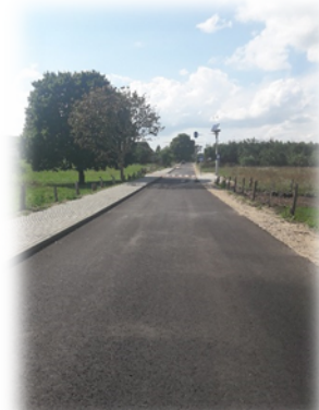
Przebudowa drogi gminnej w miejscowości Jerzwałd
