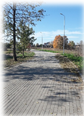
Przebudowa nawierzchni ulicy Rolnej w Zalewie
