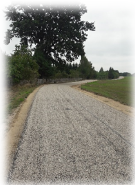
Przebudowa drogi gminnej w miejscowości Urowo
