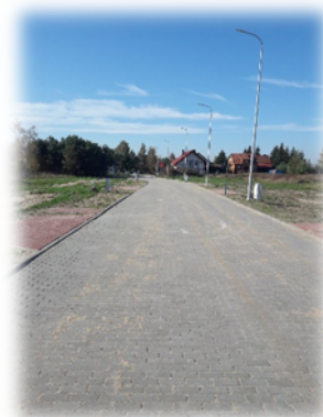
Budowa ulicy Jesiennej w Zalewie
