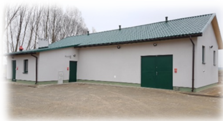
Budowa sieci wodociągowej Wieprz- Gubławki z rozbudową stacji
