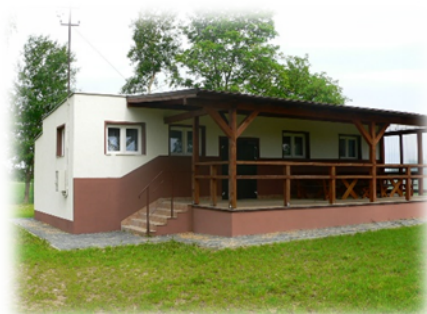
Wykonanie elewacji świetlicy wiejskiej w Półwsi
