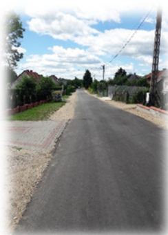
Przebudowa drogi gminnej w miejscowości Girgajny
